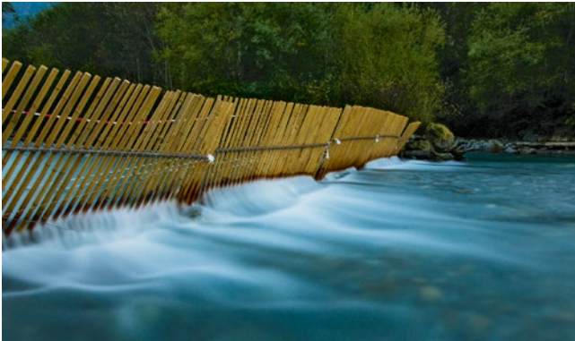
Bild 3: Die installierte Seeforellenweiche im Herbst 2014 (Quelle: Bernhardt)
