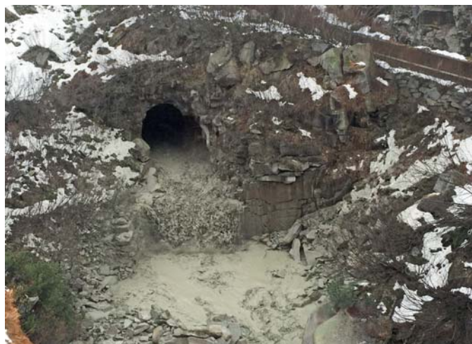
Bild 4b. Ausfluss aus dem Grundablass des Räterichsbodensees, November 2014 (Bild: Steffen Schweizer).
