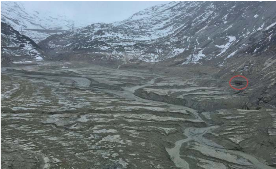
Bild 8a (ganz oben) und 8b. Vergleich des entleerten Räterichsbodensees, oben Situation von 1974 (Bild 8a) und unten Situation von 2014 (Bild 8b). Anhand des eingekreisten Bauwerks (Vorsortierwerk für den Bau der Staumauer) lässt sich die Verfüllung mit Sediment gut erkennen.
