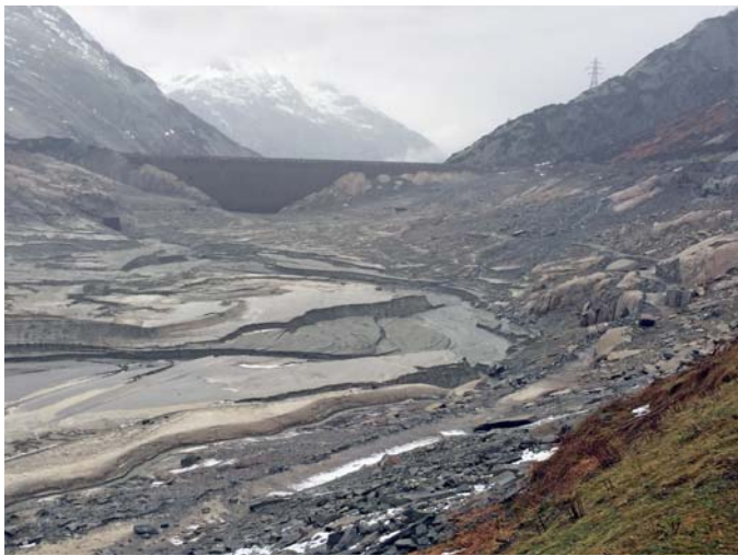
Bild 5. Foto vom leeren Stausee mit Erosionsrinnen (Bild: Stefan Schweizer).
